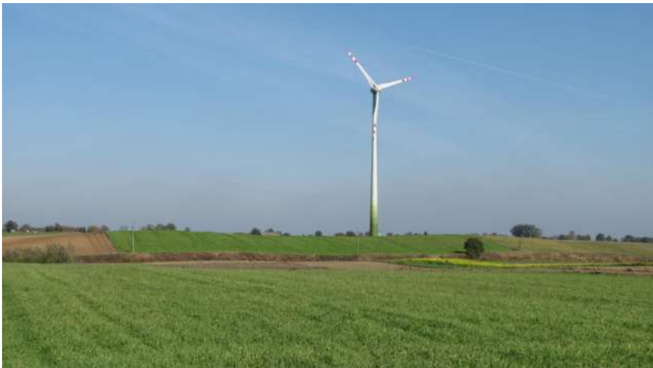
Fot. 4 Elektrownia wiatrowa na gruntach wsi Tylewo
