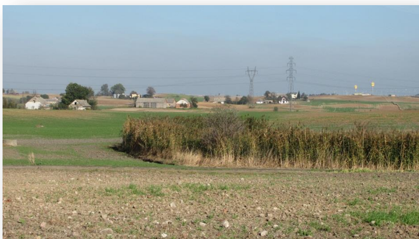
Fot.48. Malankowo – linie elektroenergetyczne
