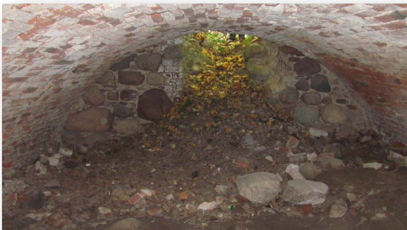
Fot.42. Lipienek – zamek sklepienie kolebkowe piwnicy
