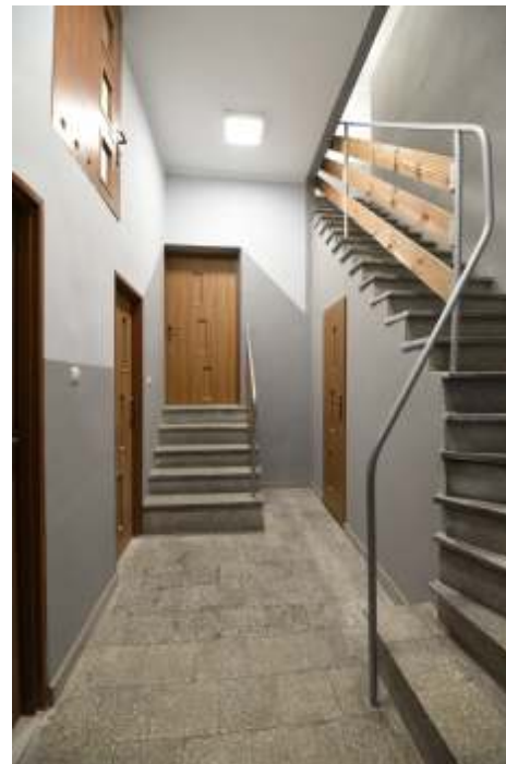
Tak po remoncie prezentuje się klatka schodowa
