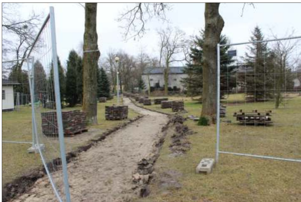
Teren został zabezpieczony, prace rozpoczęto od demontażu chodników.
